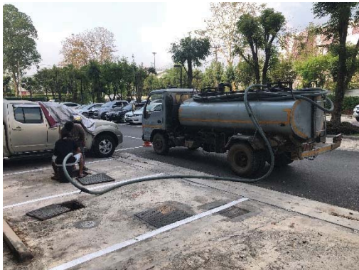
ตักน้ำจัดจัดตะกอนระบบบำบัดน้ำเสีย
