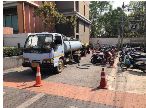
ตักน้ำจัดจัดตะกอนระบบบำบัดน้ำเสีย
