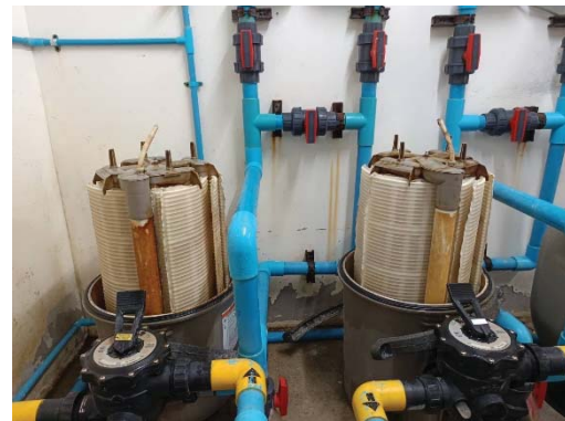
ล้างทำความสะอาดเครื่องกรองสระว่ายน้ำ
